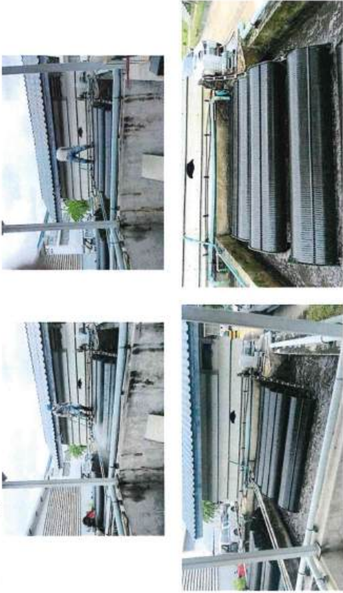
2. ทำความสะอาดลูกถังเติมอากาศ
